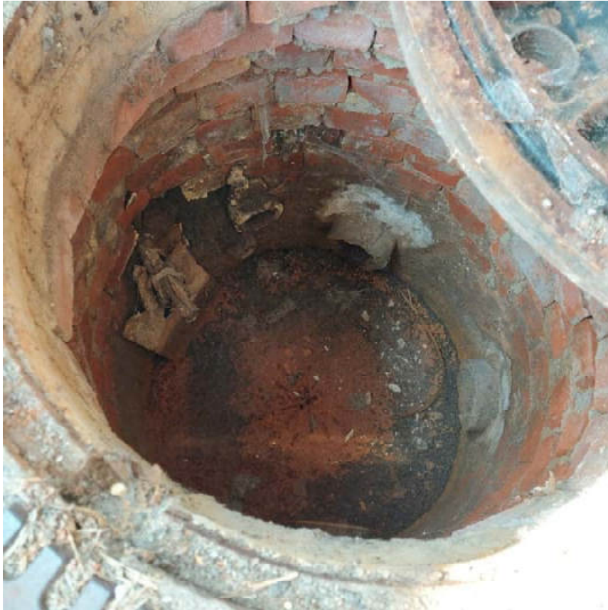
Abbildung 2: Gemauerter Kontrollschacht der Entwässerung an der BS 17
